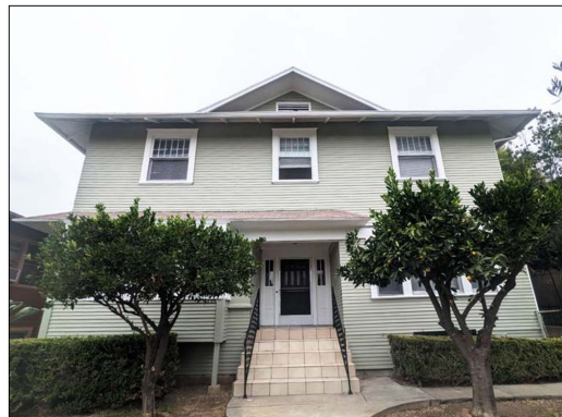
Adresa: 1421-1422 Kellam Avenue, Los Angeles, CA Două apartamente situate în partea din față a proprietății
